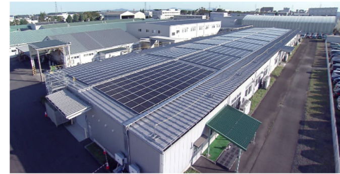
プロダクトセンター(栃木県宇都宮市)の太陽光発電設備
