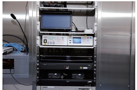
壁面に設置されたMKC-704KHDのCCUとMDR-600HD
