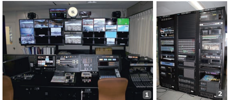
1：Ikegami の報道サブシステム 2：報道サブのラック スイッチャー「MuPS-4000」・ルーティング スイッチャー「MuPS-4000」・OnePack II を収納
