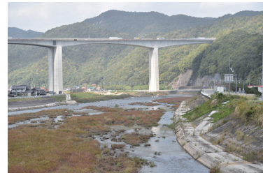
監視カメラが見守る船木大橋から見る沼田川
