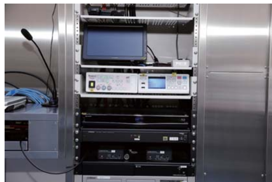
壁面に設置されたMKC-704KHDのCCUとMDR-600HD
