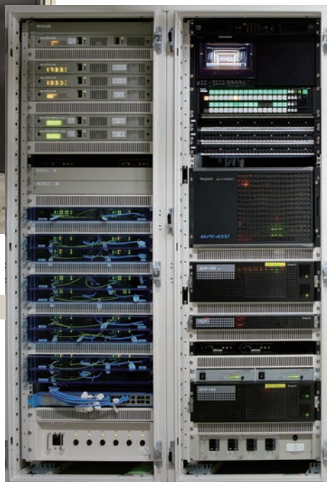
9型HDモニタ HLM-960WR カメラ切替スイッチ CTRL 32L PANEL 映像マトリクスルータ MuPS-4000 インタフェース 各制御ボード等 Onepack series
